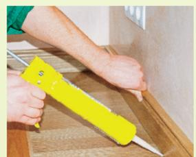
Fußleisten sollten gut mit Silikon abgedichtet werden
